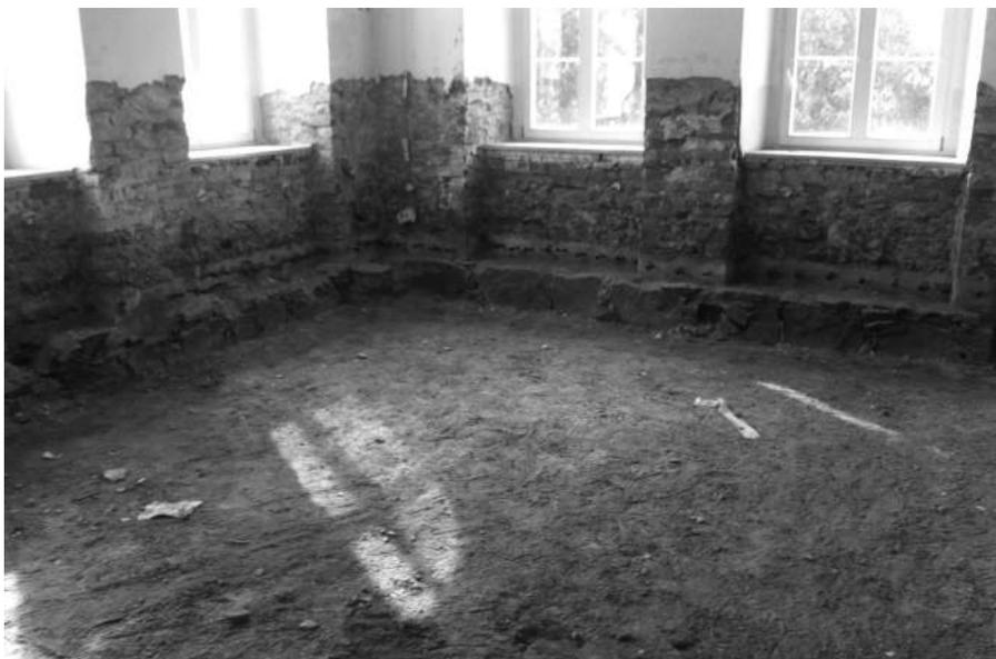
Zimmer 0.03 im Erdgeschoss nach dem Abriss des Fußbodenaufbaus
